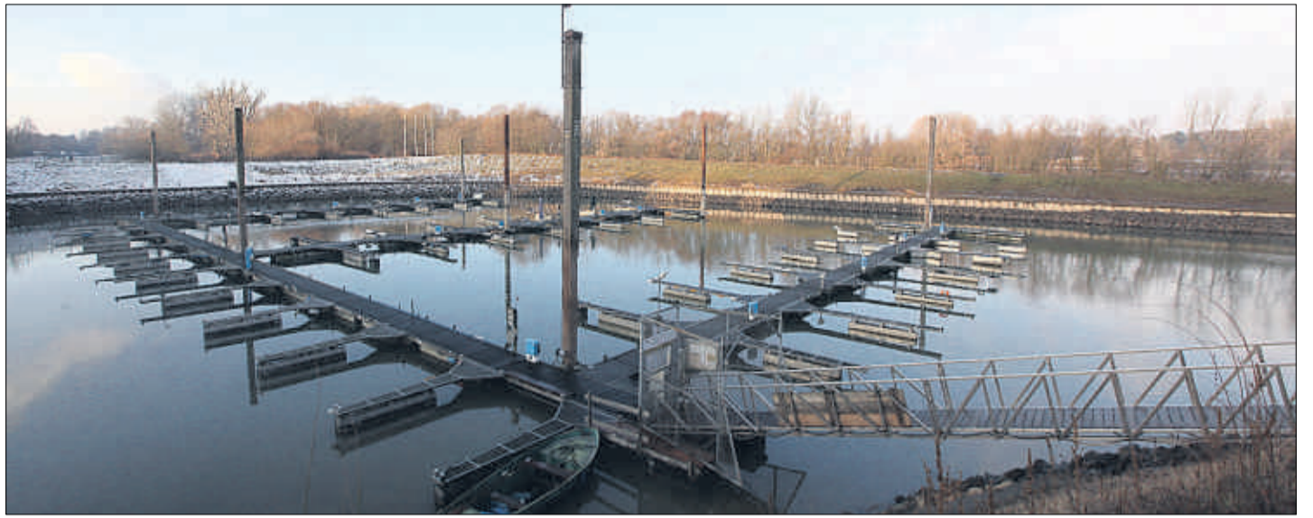
Ausgebaggert werden soll der Zündorfer Jachthafen, in dem auch die Holzdalben erneuert werden sollen. (Foto: Denzer)
